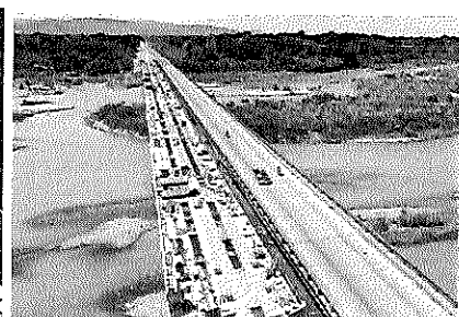
Puente 27: Km 125+309,60, Río Chirripó
