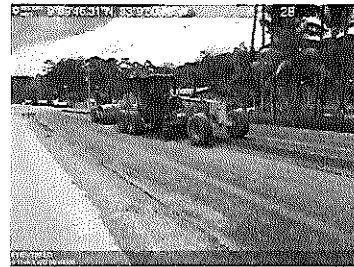
Trabajos de relleno en Km 140+750 LD
