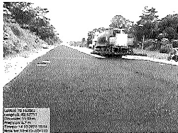
Riego de emulsión asfáltica para imprimación Km 80+610 al 80+310
