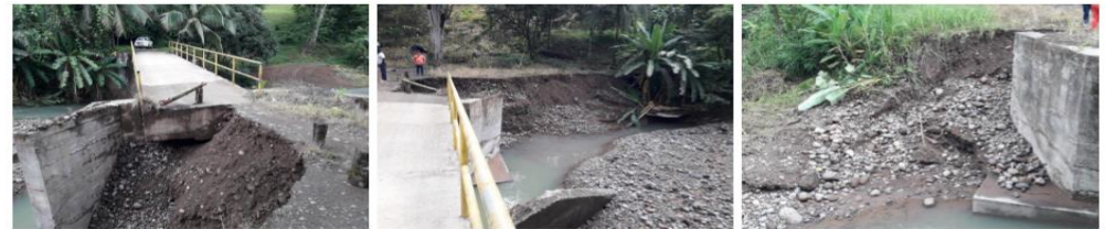
Erosión de las márgenes del río Pérdida total de material granular en las aproximaciones del puente
