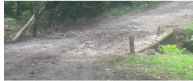
Paso de alcantarilla en San Cecilio.
