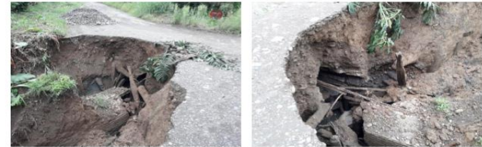
Dstrucción de camino y colapso de paso de alcantarilla
