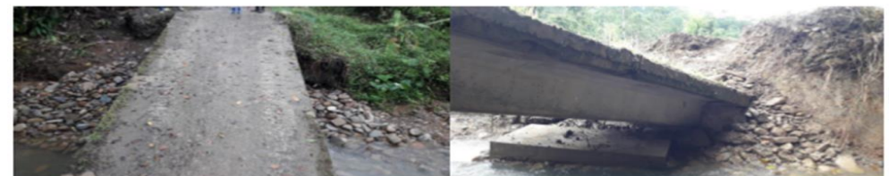
Puente sector Pozos de Victoria
